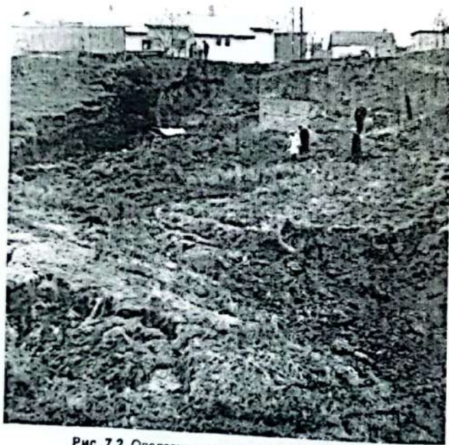
Рис. 7.2. Оползень суглинков по скифским глинам по ул. Профсоюзной, на б. Климова
